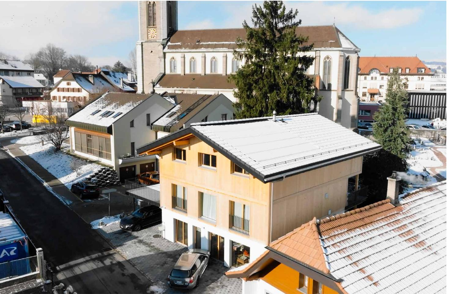
Das renovierte Haus vereint nun eine traditionelle Bauweise – eine Struktur aus heimischem Holz und eine Fichtenholzfassade – mit modernster Technologie: Geheizt wird mittels einer Erdwärmesonde, einer Wärmepumpe und einer Solaranlage mit einer Fläche von 60 m<sup>2</sup> auf dem Dach.
