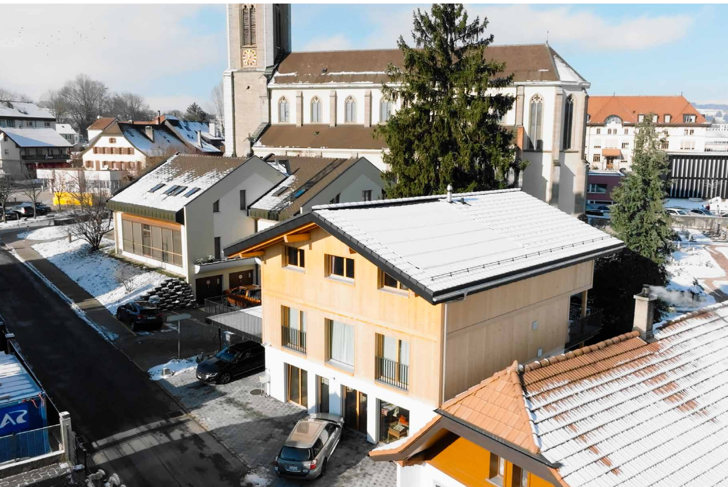
Dotée d'une structure en bois local et de façades en épicéa, la maison rénovée allie construction traditionnelle et technologies actuelles : chauffage par sonde géothermique, pompe à chaleur et 60 m 2 de panneaux solaires en toiture.
